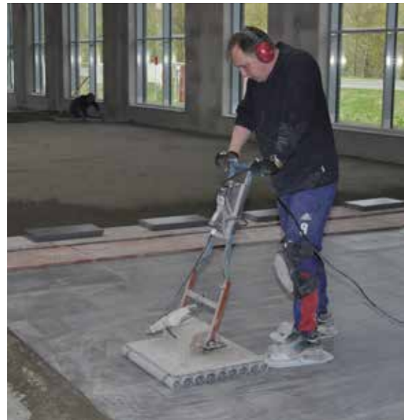
Bardzo wydajne układanie metodą wibracyjną
