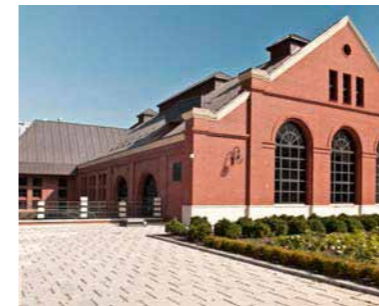
Stacja Ozonowania Wody w Warszawie s. 12
